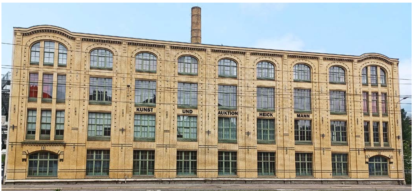
Das industrielle Erbe in Chemnitz ist überwältigend. Noch warten viele Industriebauten auf ihre Restauration und Neunutzung (Bild: D. Aufschläger)
